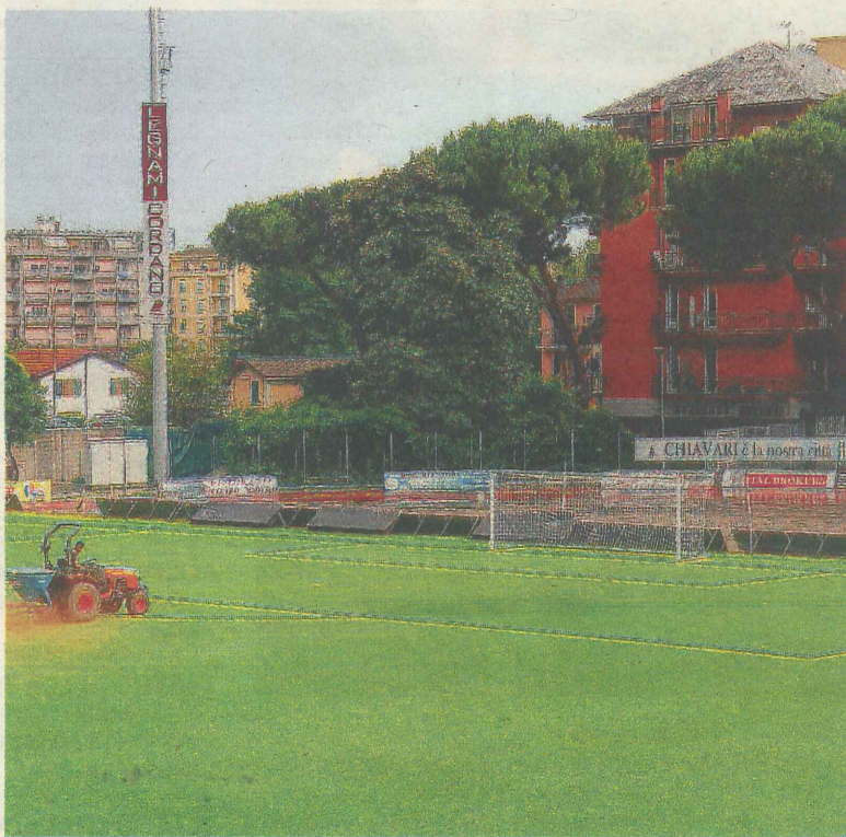
La zona dello stadio in cui sorgerà la nuova gradinata Sud
